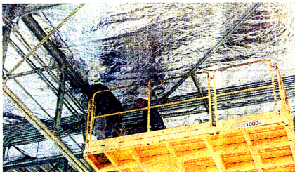
天井に遮熱シートを取付
