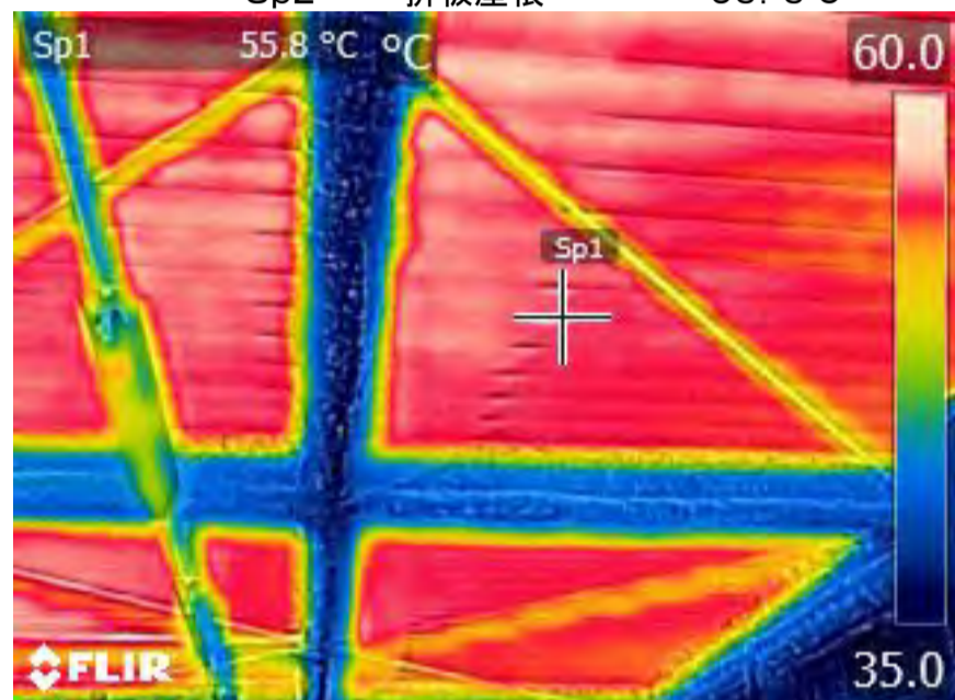
Sp1 折板屋根 55.8°C
